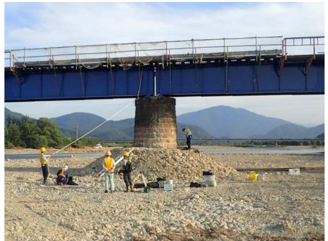
写真1 埋戻しの状況
