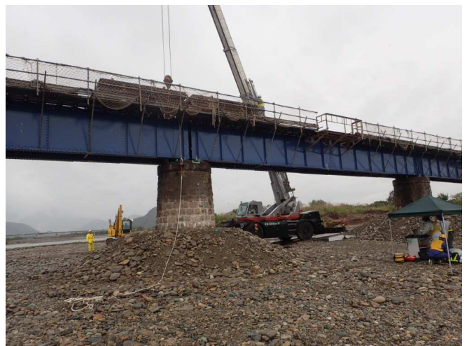
写真2 載荷試験の状況
