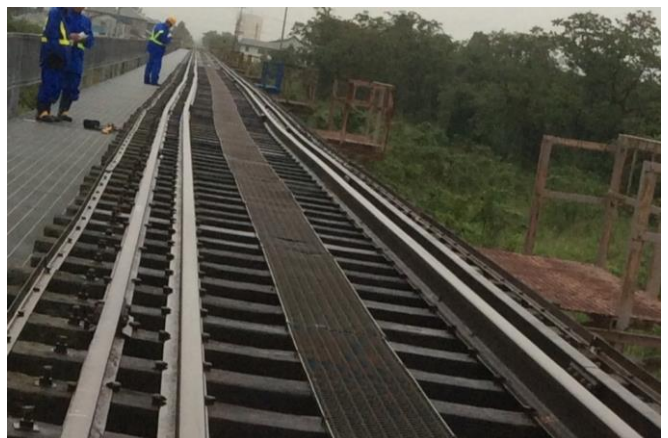
写真 2 被災直後の橋脚状況
