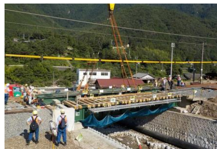
図8 下り線工事桁架設状況
