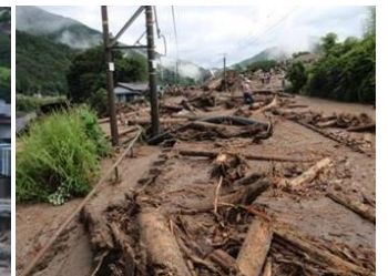
図3 橋りょう前後の被災状況
