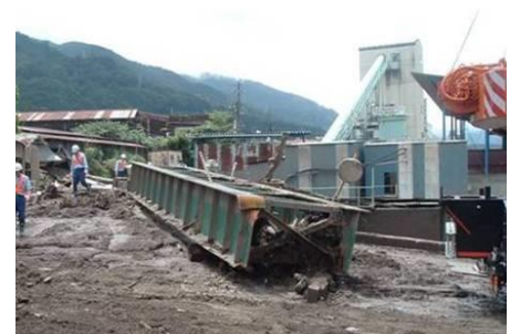
図5 流失した下り線の橋けたの状態
