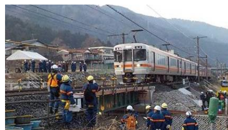
図10 下り線新桁架設後の初列車確認
