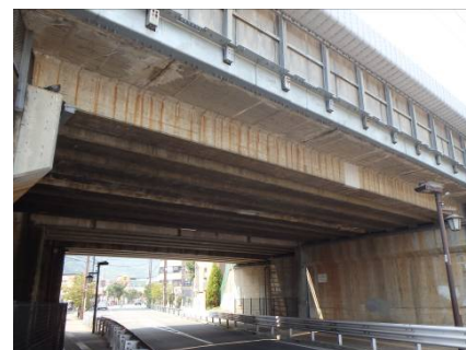
写真-1 対象橋りょう全景写真
