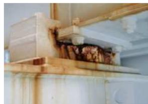
写真-1 縦桁支承のさび
