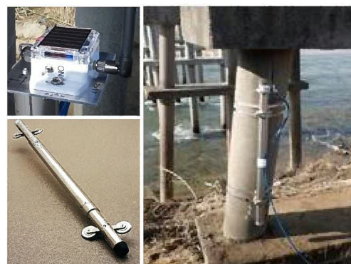
写真2 センサー取付状況
