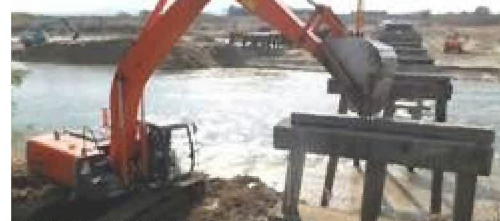
写真3 橋脚載荷重状況
