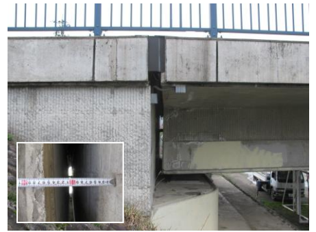
写真-5 対象橋梁の桁端の外観
