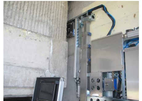
写真-6 桁端部進入状況
