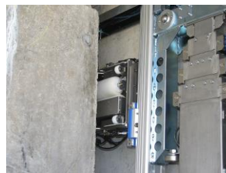
(a) 施工状況
