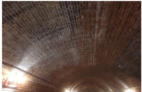
写真-4 施工完了時の状況
