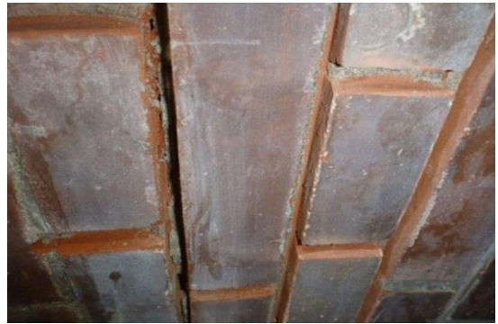
写真-3 目地撤去後の状況
