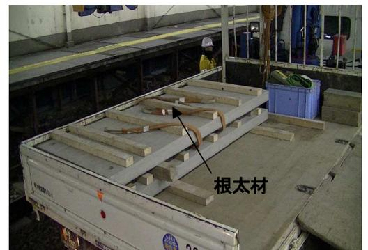
図-7 PC板根太材設置状況
