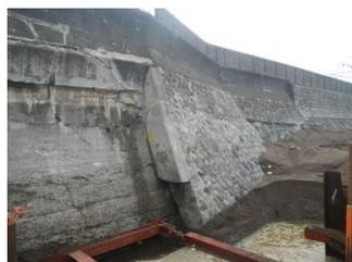
図-4. 目地破損状況
