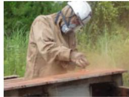
図-7 動力工具による除去
