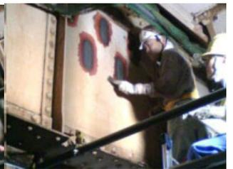
図-9 施工状況(左:加熱、右:塗膜除去)
