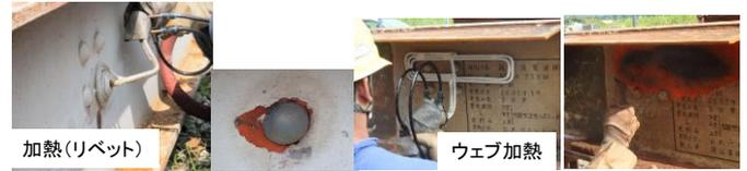
図-1 加熱状況と塗膜除去状況
