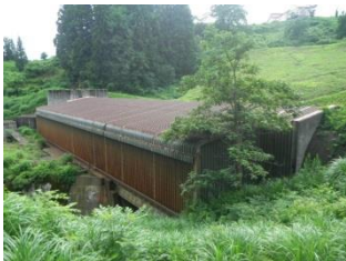
図-1 雪覆い工全景
