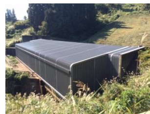
雪覆い工全景
