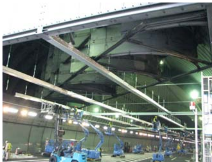
写真-3 特殊架台による狭小部の施工
