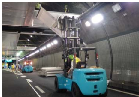
写真-2 特殊フォークリフトによる施工
