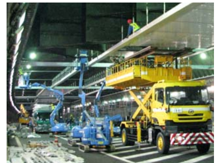
写真-3 特殊架台による狭小部の施工
