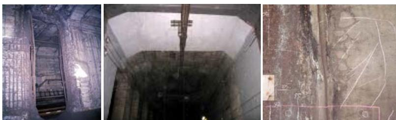
写真-1 変状 写真-2 対策完了状況 写真-3 再劣化状況
