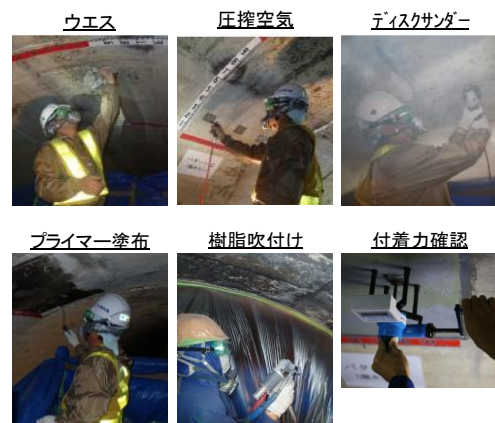
図-4 施工状況写真
