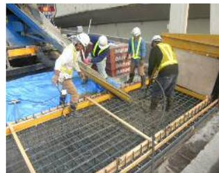
写真-4 コンクリート打設
