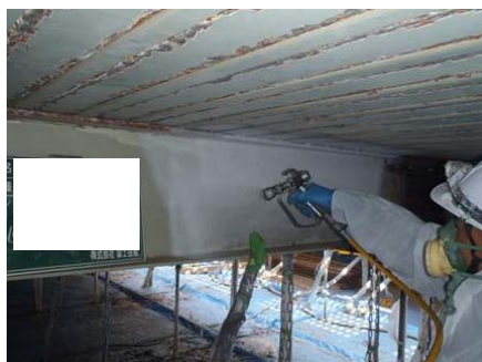
剥離剤 B 塗布状況
