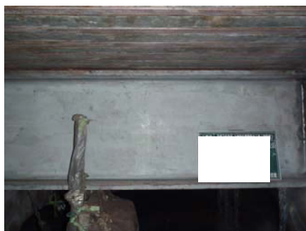
剥離剤 B 塗膜除去後
