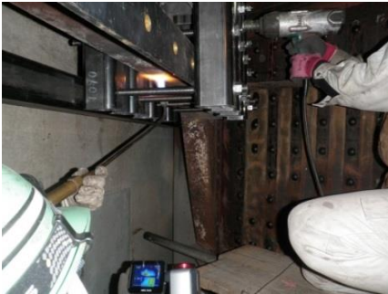
写真-2 矯正施工状況
