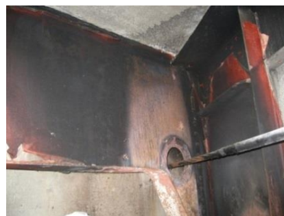
写真-1 補修対象端横桁
