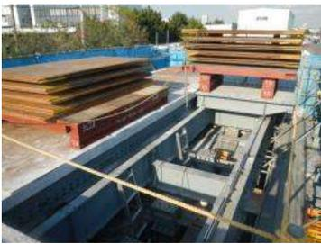
写真-1 上載荷重載荷状況
