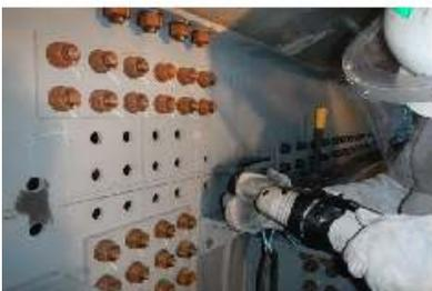
写真-3 同セイバーソウによる切断
