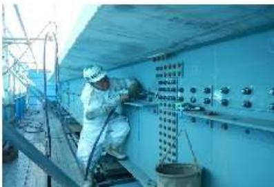
写真-2 腹板のガス切断状況
