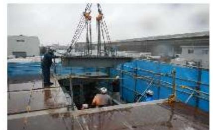
写真-9 鋼床版設置状況
