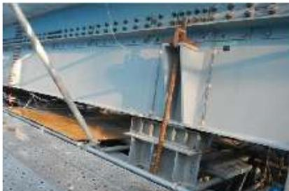
写真-4 主桁側支持桁吊構造設置部
