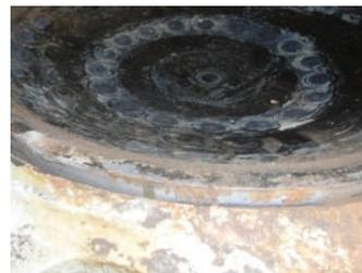
写真-3 下査内部すべり面の状況
