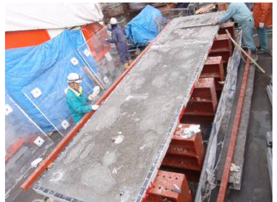
写真-1 洗浄作業状況
