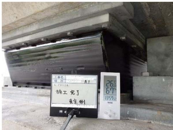
図-3 K-PRO 工法 既設橋への適用例
