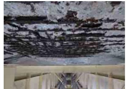
写真-1 床版下面の劣化状況
