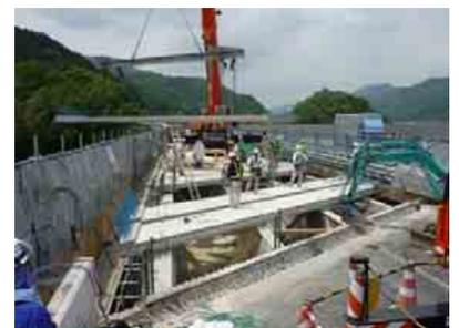
写真-2 PCaPC床版の架設
