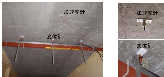
写真-1 床版たわみ計・加速度計設置状況
