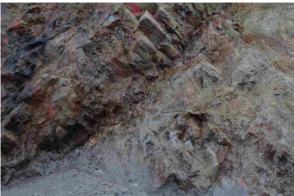
図－２ サンルダムの岩盤
