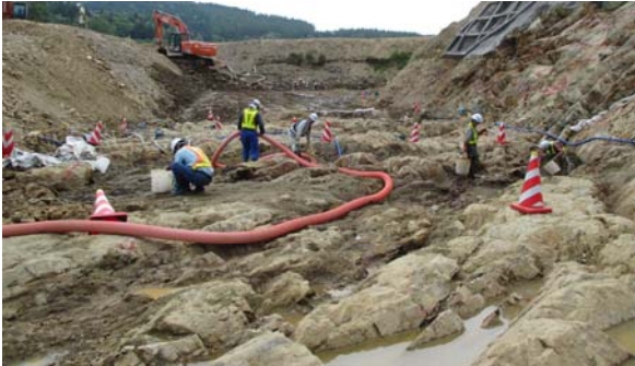
図－１ 岩盤清掃状況
