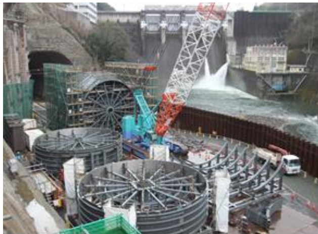
写真-2 坑外にて1基3mの単管に組立溶接
