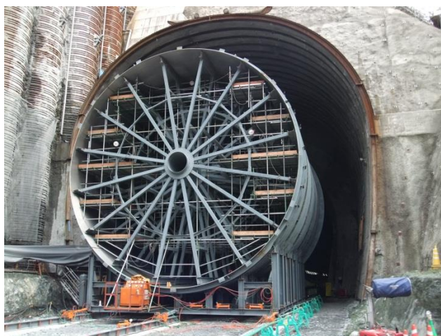
写真-3 トンネル内への押込み (15t 油圧ジャッキ2台使用)
