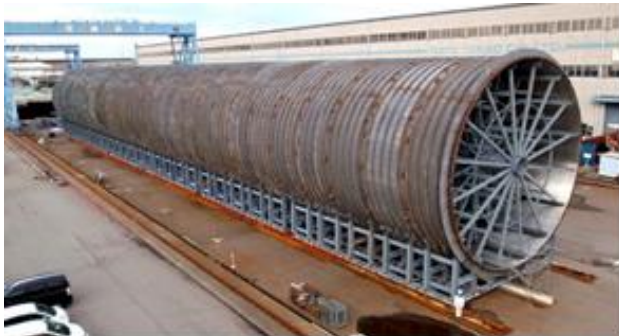
写真-1 工場部材製作・全延長仮組立
