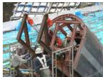
写真-5 スライド(滑車使用)状況
