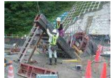
写真-3 側溝枠の解体～設置
