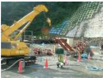
写真-1 レールのスライド
