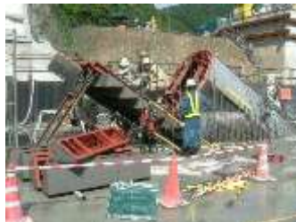
写真-2 階段枠の解体～設置
