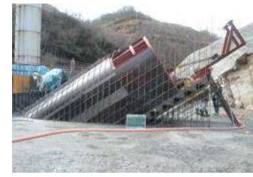
写真-6 スライド型枠の設置完了(打設前)
