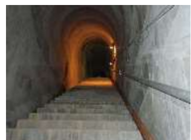
写真-7 監査廊の内部仕上がり状況
