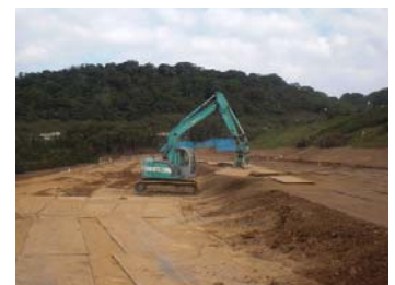
写真－2 鉄板の敷設替えに使用したマグネット式バックホウ
