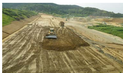
写真-3 盛立の状況
