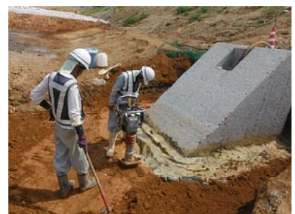
写真-5 旧取水設備の漏水対策状況
