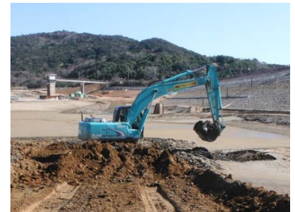
写真-3 堆積泥土の撤去状況
