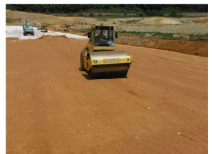
写真-4 ブランケット補強盛土の転圧状況
