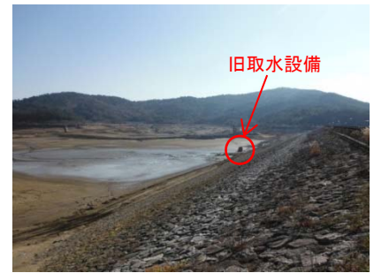
写真-2 貯水位低下後のブランケット補強盛土施工範囲の状況
