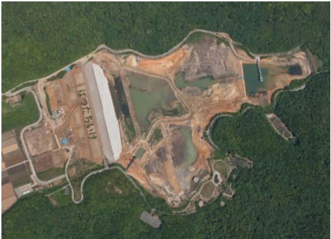
写真-1 初立池の全景(盛立中)
