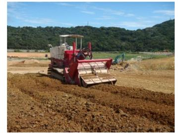
写真-3 スタビライザによる攪拌混合状況
