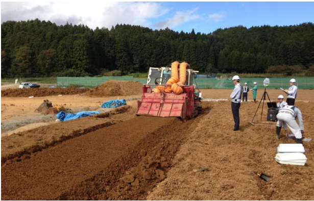
図-2 現地試験の状況
