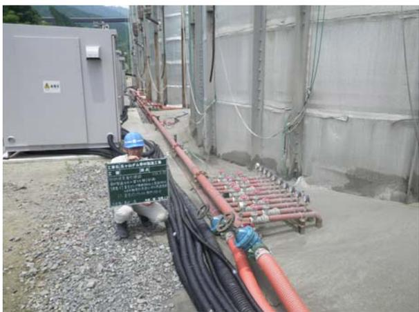
写真-3 ストレーナ管配管状況
