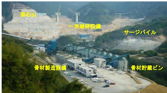
写真-1 骨材製造設備全景（平成 27 年 10 月）
