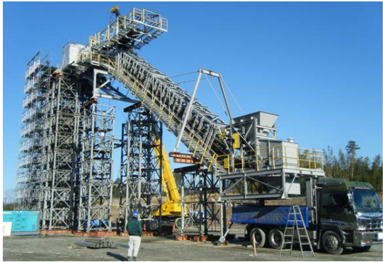
写真-1 実証実験状況
