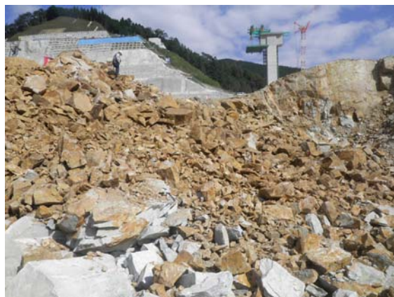
写真-2 混在岩の状況（発破後切羽）
