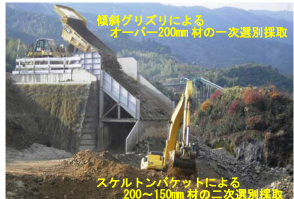
写真-4 混在岩の選別状況
