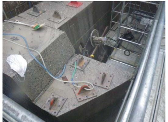
写真-2 ワイヤソーイングの施工状況
