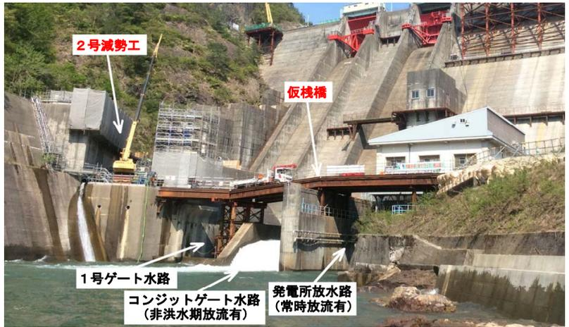
写真-1 減勢工の施工状況
