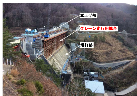
写真-2 クレーン走行用構台の設置状況
