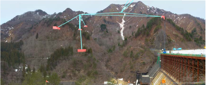
写真－1 右岸側クレーン基礎の予定位置
