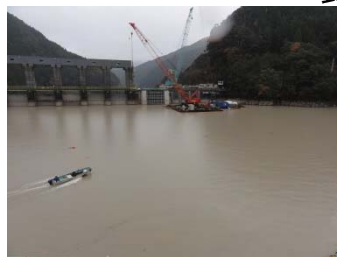
写真-2 長安口ダム貯水池の状況
