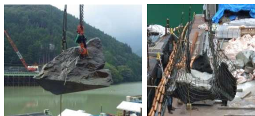
写真-2 岩盤揚重状況
