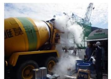
写真-2 液化窒素によるプレクーリング状況
