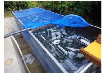
写真-1 練混ぜ水の冷却状況
