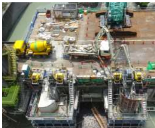
写真-2 予備ゲートピア躯体の施工状況
