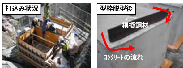
写真-1 試験施工の状況
