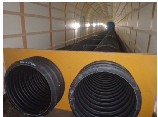
写真-1 養生写真
