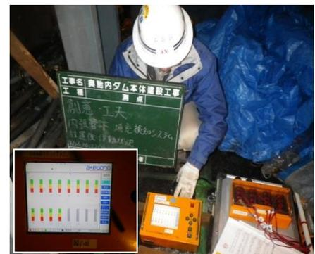
写真-5 コンクリート充填確認状況
