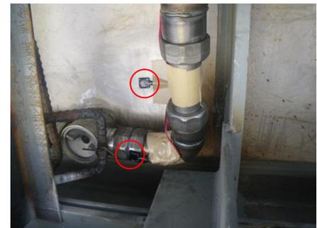
写真-4 充填センサー設置状況
