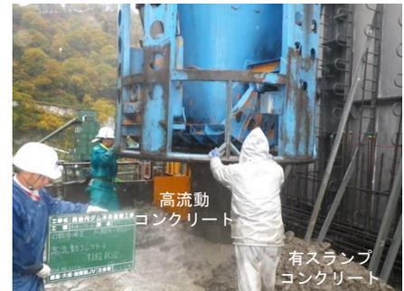
写真-3 高流動コンクリート打設状況
