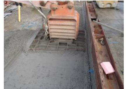
写真-2 締固め状況
