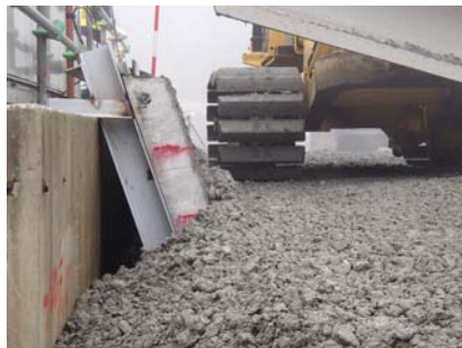
写真-1 PCa コンクリート際の RCD コンクリート施工状況
