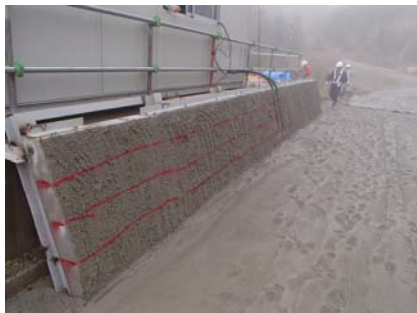
写真-1 PCa コンクリート際の RCD コンクリート施工状況
