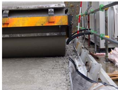
写真-1 PCa コンクリート際の RCD コンクリート施工状況
