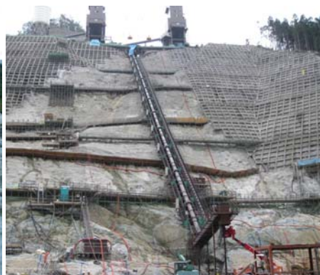
写真-2 SP-TOM の全景 (湯西川ダム)
