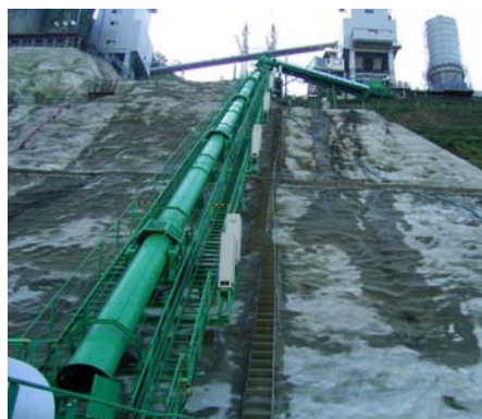
写真-1 SP-TOM の全景 (嘉瀬川ダム)
