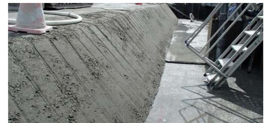
写真-2 端部法面仕上り状況
