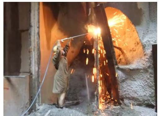
写真-2 シャープランス切断状況
