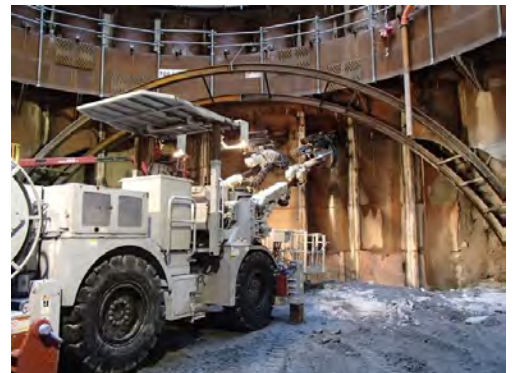
写真-3 フォアポーリング施工状況
