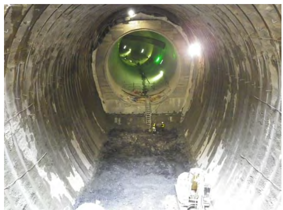
写真-5 掘削完了状況
