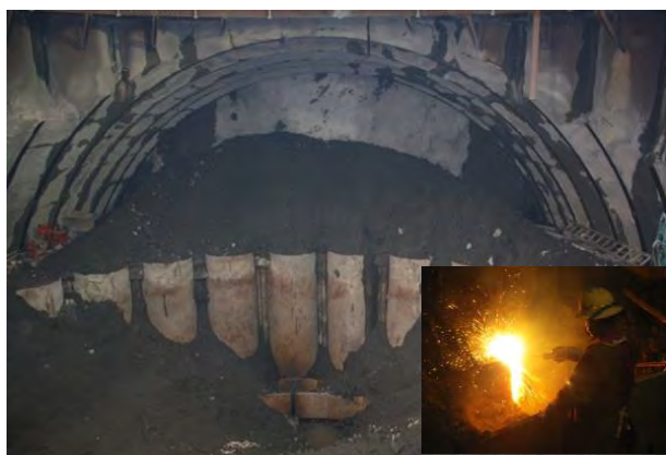
写真-4 リング支保工切断状況
