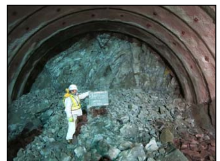
図-1 非火薬剤使用時の破碎状況
